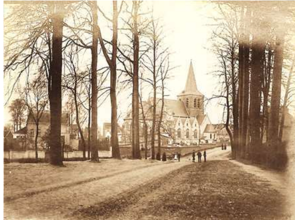
Achterzijde van de kerk en de pastorie van Dilbeek op 12 april 1908 met mooi zicht op het inmiddels verdwenen gedeelte van de kerkhofmuur (Eigen archief)
